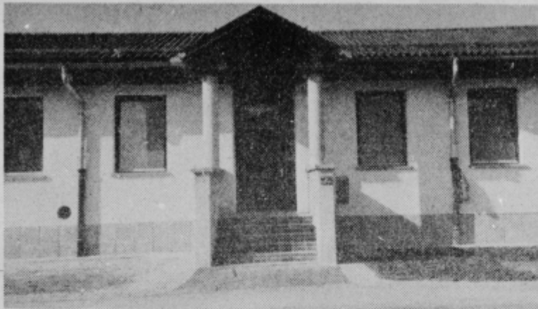
V letošnjem letu so v Komunalni Celje pridobili tudi novo vodarno v Medlogu. Skupaj s še dvema novozgrajenima vodnjakoma pomeni to približno 80 sekundnih litrov več v celjskem vodovodnem omrežju.
