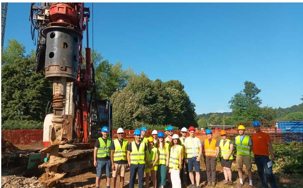
Sl. 1. Ogled vrtnja pilotov na gradbišču ZP Ljubljana.
