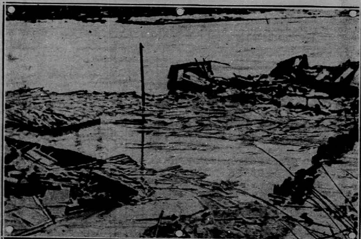
V mestu Santo Domingo, ki ga je orkan skoro popolnoma uničil, se vrše reparacijska dela. Na tisoče in tisoče delavcev je zaposlenih, ameriške ladje pa dovažajo potreben material. Slika nam kaže opustošeno obalo po viharju.
