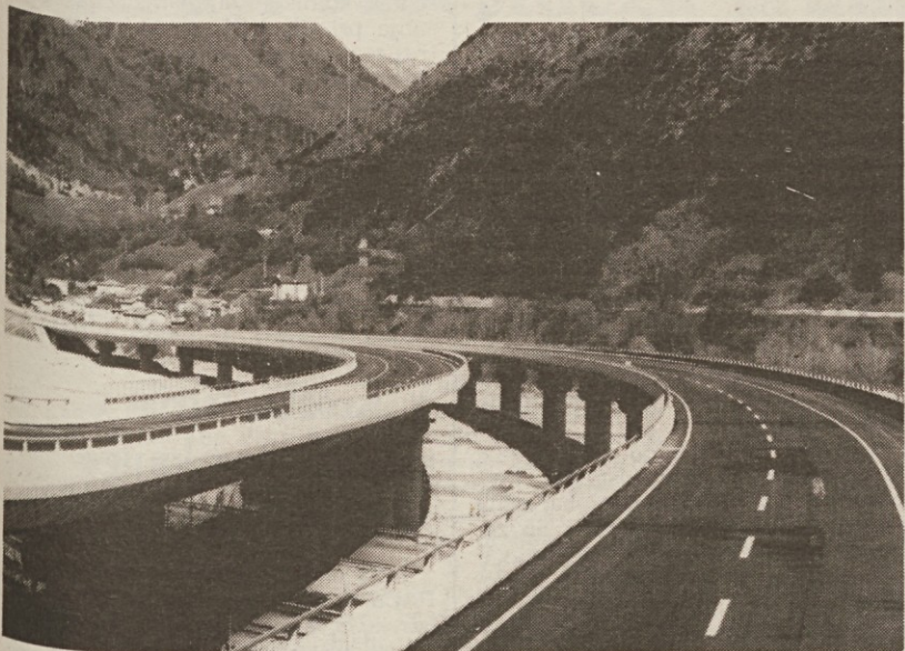
Viadukt Bela I. na novem avtocestnem odseku
