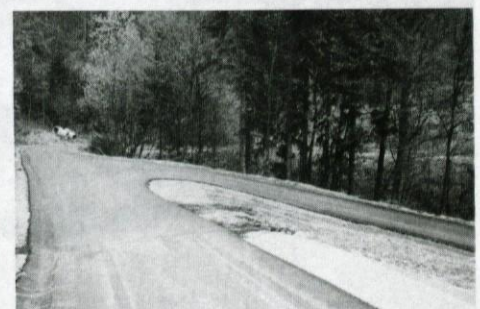
Novi metri asfalta proti Gorenju
