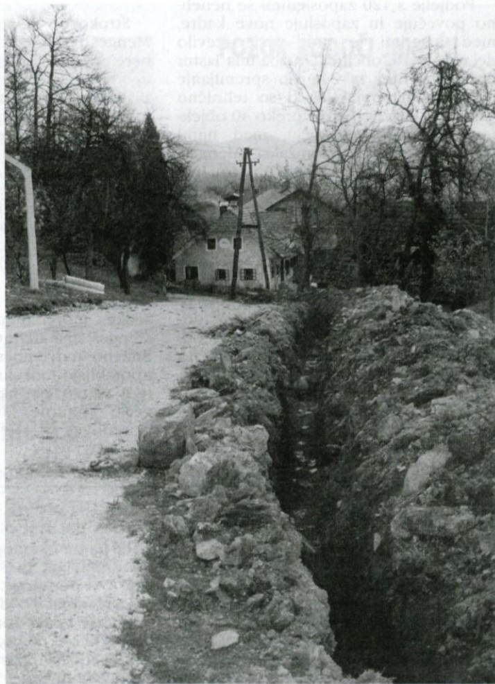
Izkop za električni kabel v Velikem Jelniku
