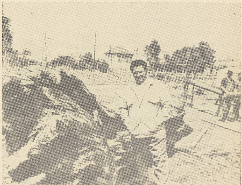
Pri izkopu za objekt industrije oblačil v Ljutomeru so v globini 3 metrov našli na dobro ohranjen hrast premera 1,5 metra. Strokovnjaki sodijo, da je bil star 250 let, v zemlji pa je ležal več kot 1500 let
