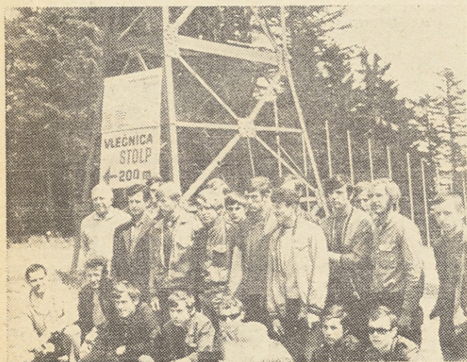
Skupina vajencev gradbenega podjetja Bytostav iz Moravske Ostrave na zelenem Pohorju
