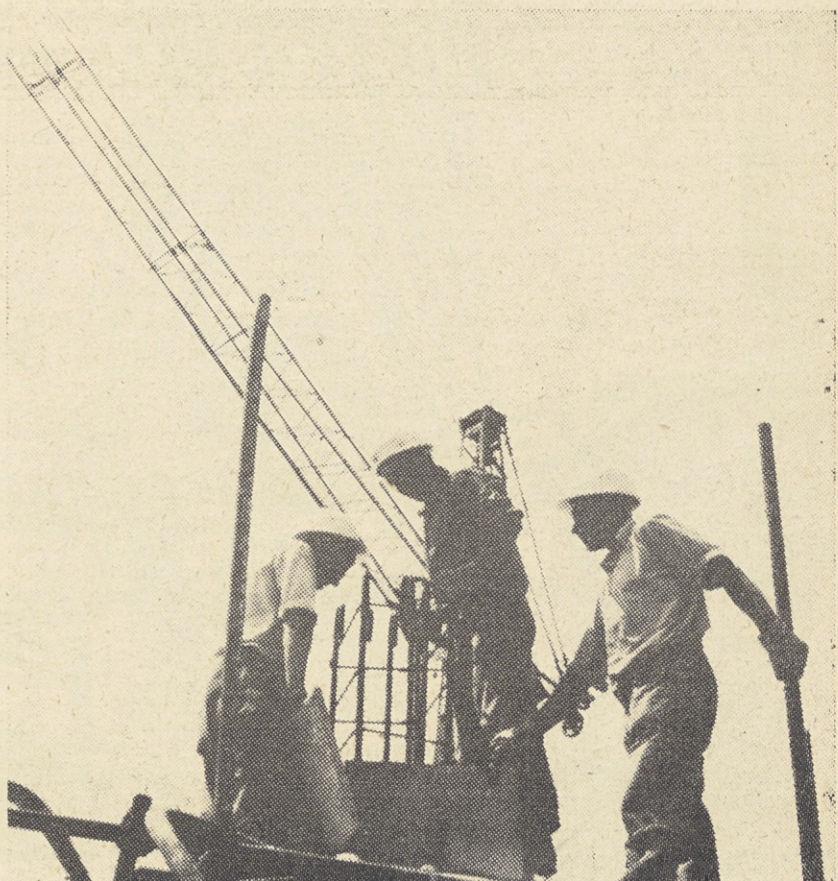
Na gradbišču industrije oblačil »Mura« — podružnica Indopol — v Ljutomeru
