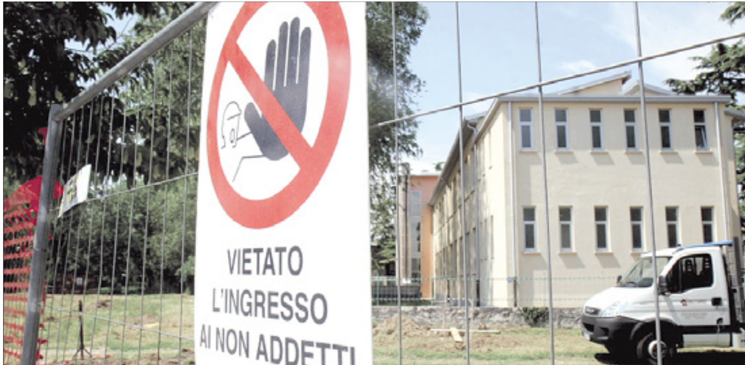
Gradbišče novega šolskega središča so zavarovali tudi z mrežami
