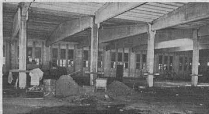
V novi hali bodo začeli z notranjimi deli
