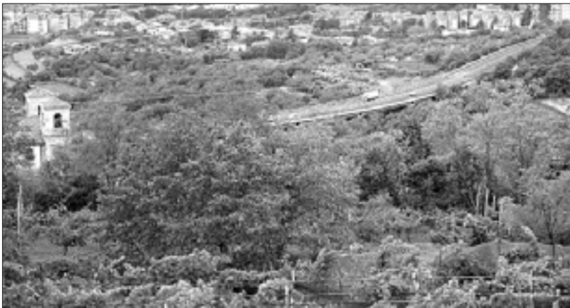
Z zvočnim onesnaževanjem avtoceste se bo ukvarjala posebna komisija KROMA
