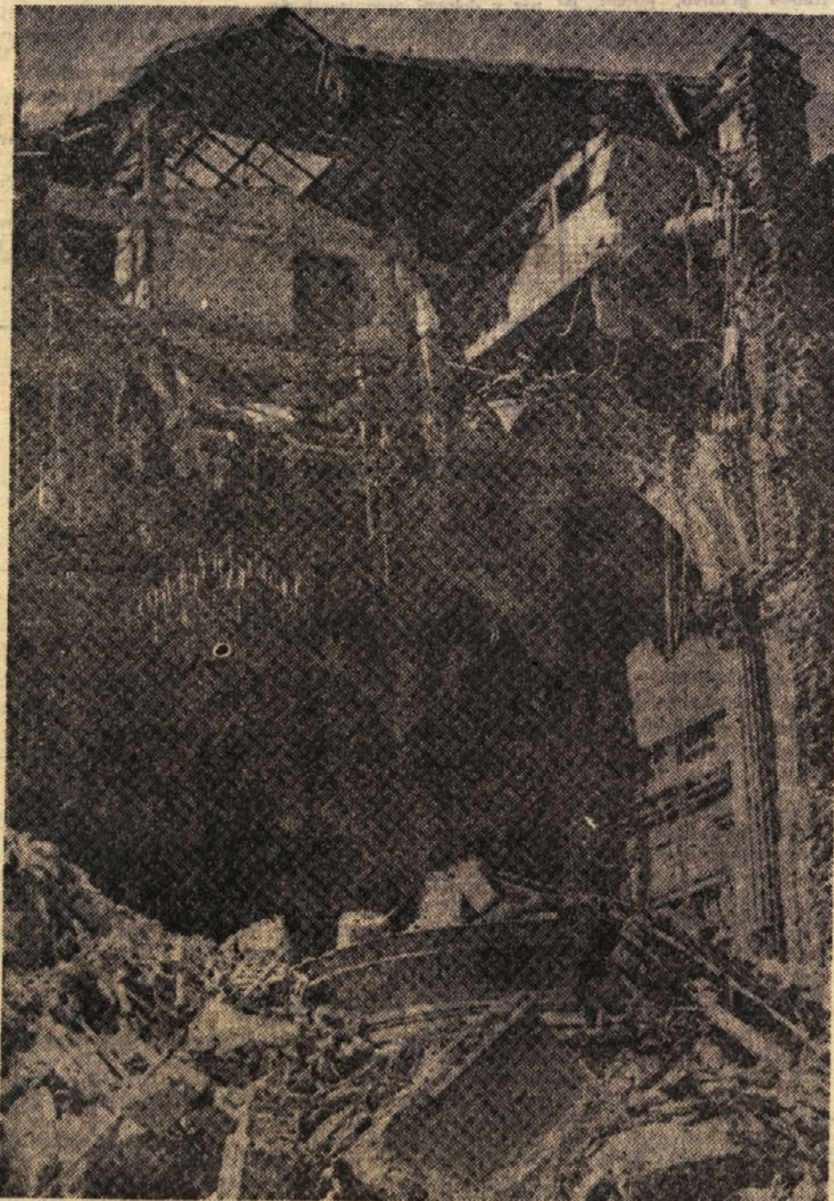
V ZRAK STRLE TUDI OSTANKI PORUŠENEGA DOMA JLA in odkrivajo pogled na nekoč krasno dvorano doma; visoki okrašeni nosilni stebri še nosijo kos stropa, na katerem še visita dva velika starinska lestenci, značilna za svečane kazinske dvorane polpretekla stoletja
