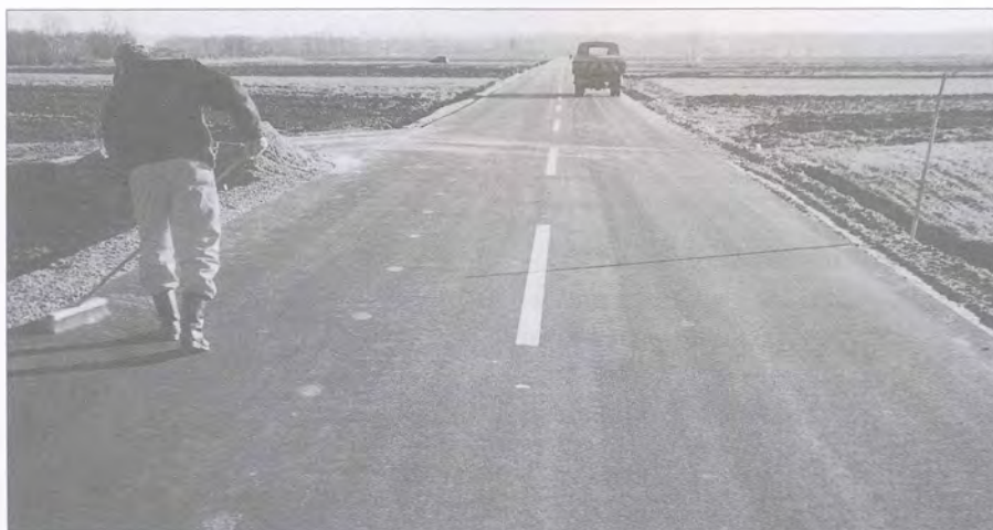
Izgradnja ceste Beltinci – Melinci – Gornja Bistrica je v zaključni fazi
