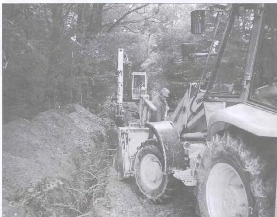
Tehnični pregled vodovoda Gančani-Beltinci je bil uspešen
