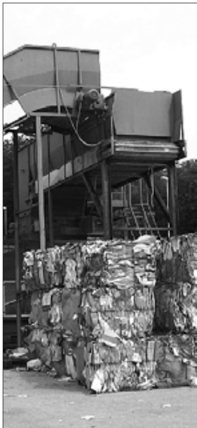
Center za ravnanje z odpadki Stara Gora
