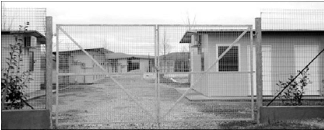
Gradbišče novega pesjaka pri Ločniku
