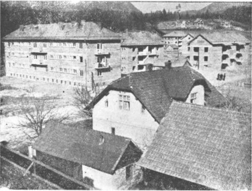
Del Novega Velenja v izgradnji
