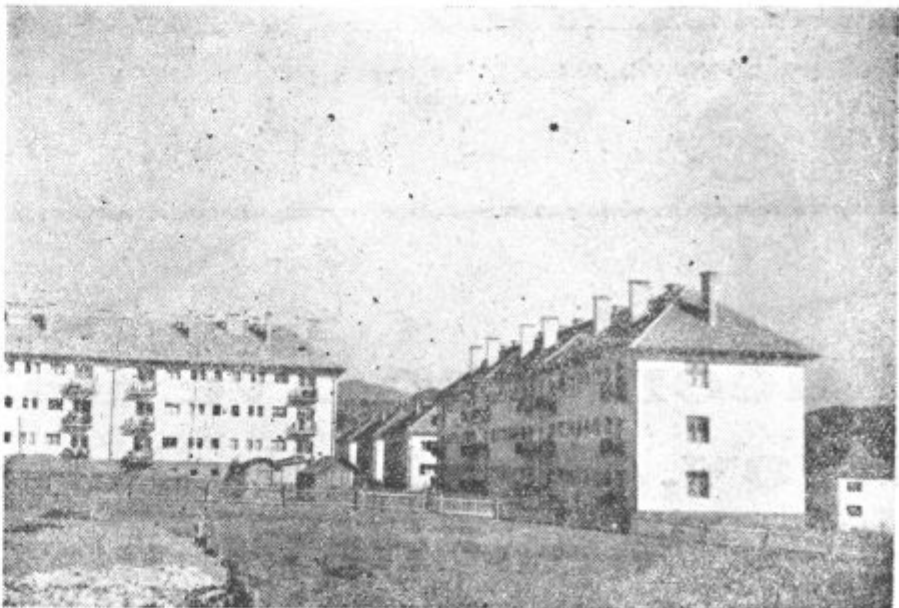
Ze zgrajeni del Novega Velenja
