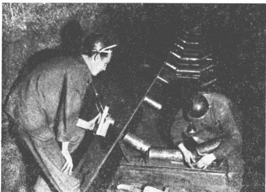
Pri montaži transportnega traku
