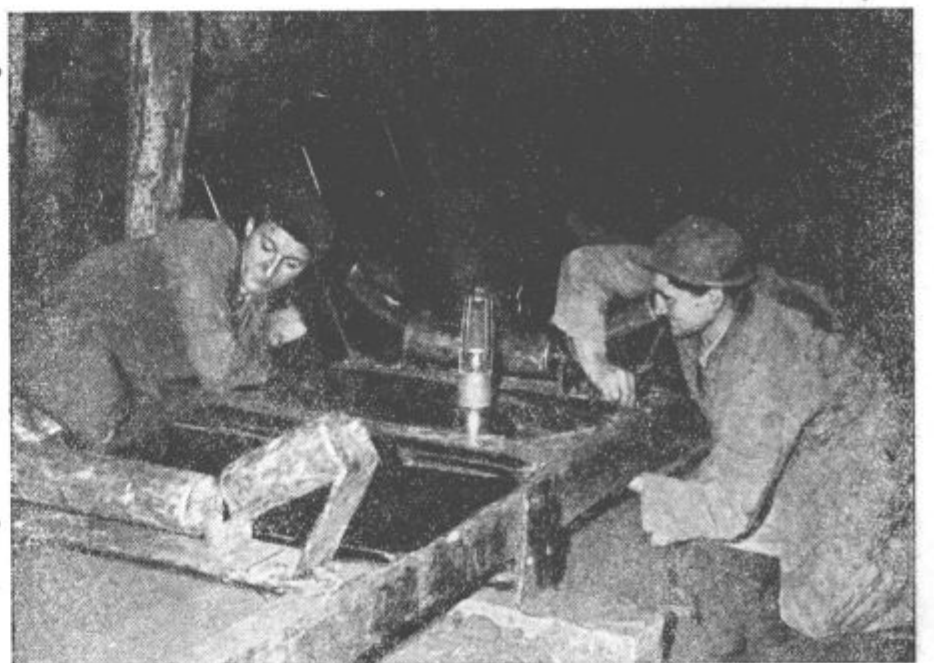
Pri montaži transportnega traku
