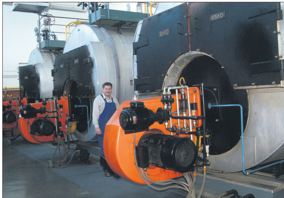
Foto: M. Ozmec Za ogrevanje novega dela spalnega naselja in Ptuja so na voljo tri velike peči na zemeljski plin.
