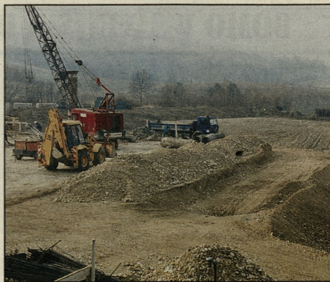
Gradnja nove hladilnice
