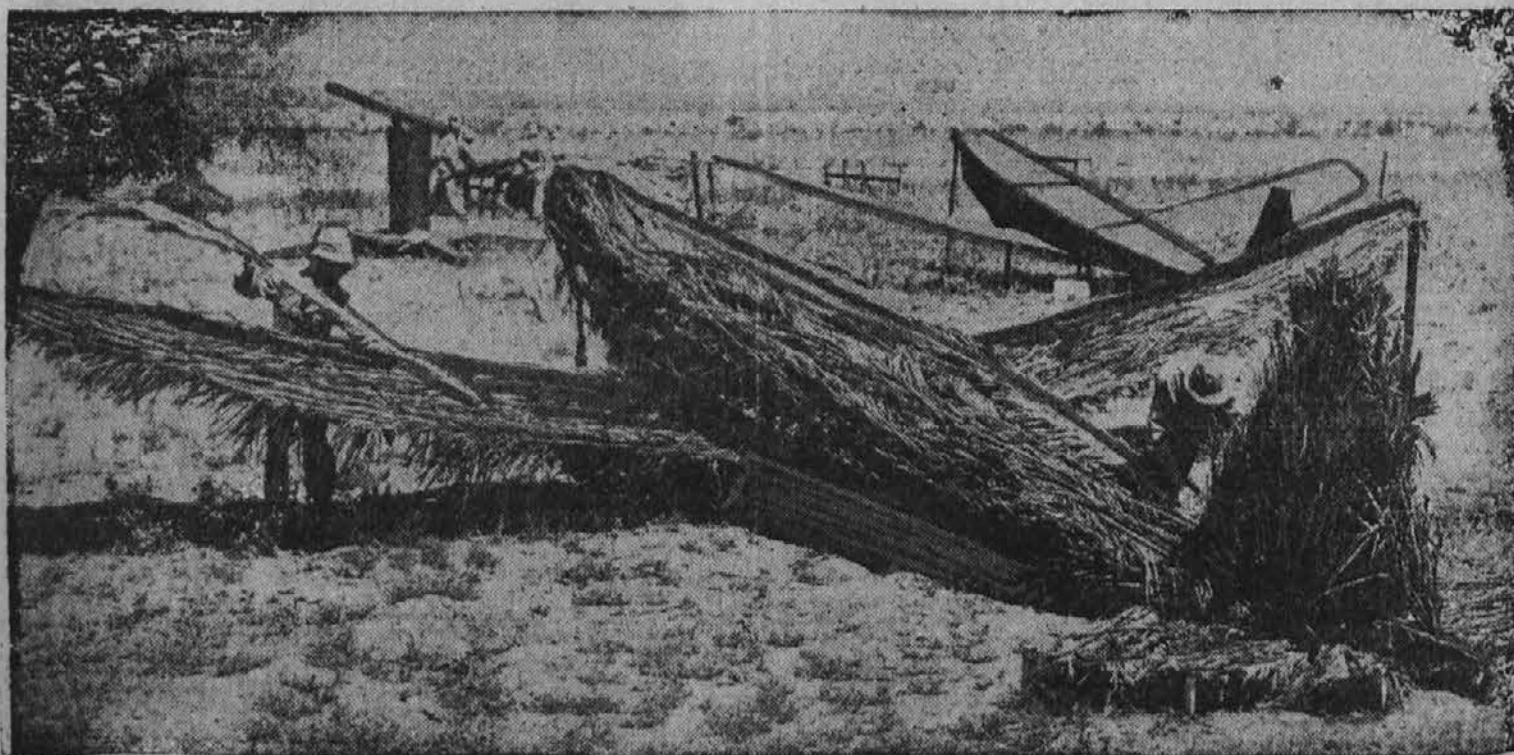
Da premotijo sovražne letalce so se naši inženirji izmislili in napravili novo prevaro. Na sliki vidimo navidezno letalo, ki je napravljeno iz raznih vej in druge šare, vendar pa iz višine 3,500 čevljev, bi vsak pilot mislil, da je resnično letalo na tleh.
