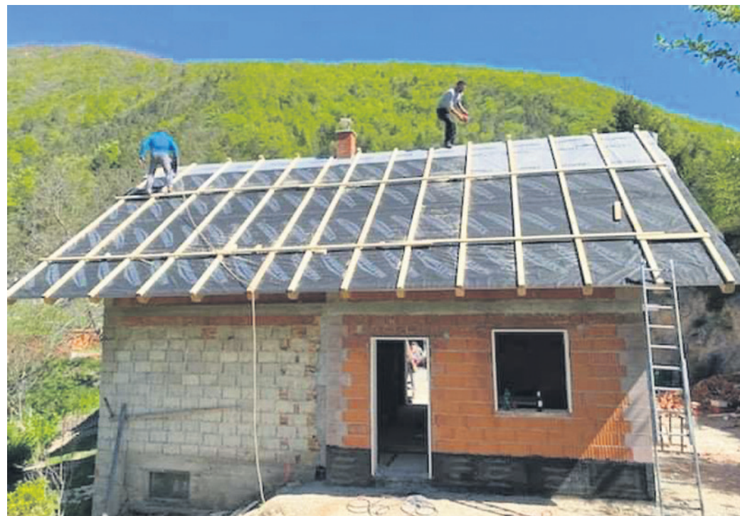
Številni podjetniki in obrtniki iz bližnje in daljne okolice so pomoč ponudili tudi v obliki dela in materiala za obnovo, pri čemer je les za gradnjo prispevala družina Dolar iz lastnega gozda. S pomočjo številnih prostovoljcev je bodoči dom Dolarjevih že pripravljen na montažo strešne kritine.
