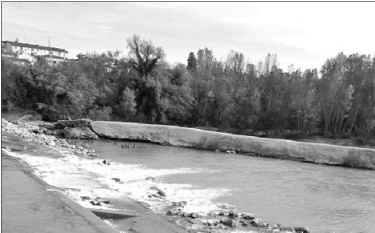
Ostanki starega jezu ovirajo tok reke in ga usmerjajo proti desnemu bregu
