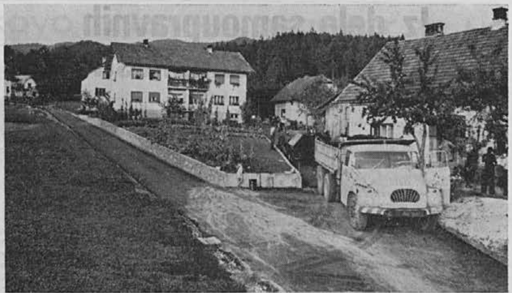
Asfaltiranje je za letos zaključeno. Ni tako poceni...
