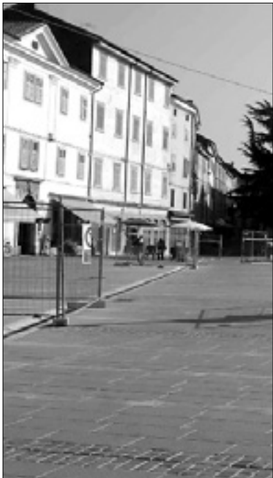
Gradbišče na Travniku
