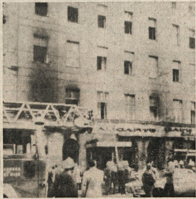
Pročelje dunajskega hotela po požaru
