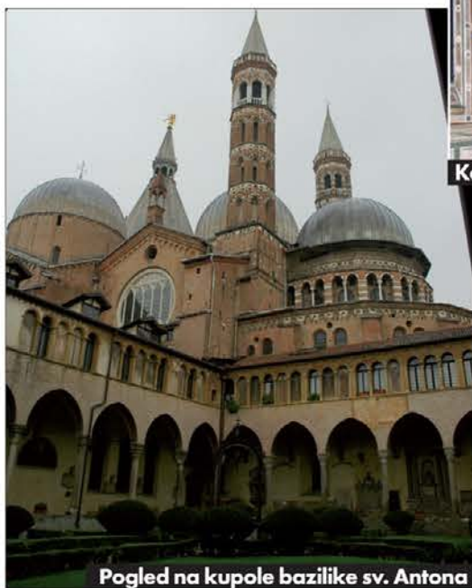
Pogled na kupole bazilike sv. Antona
