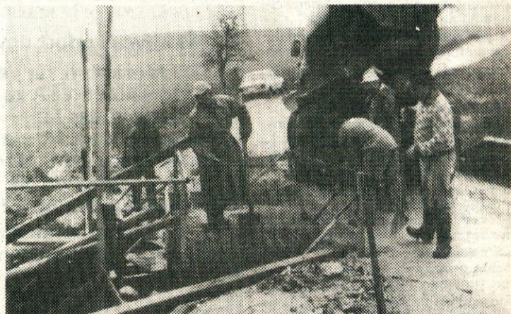
Krajski Spodnjega Tustanja so takole betonirali, ko so poprav- ljali most preko Rače pod vasjo.
