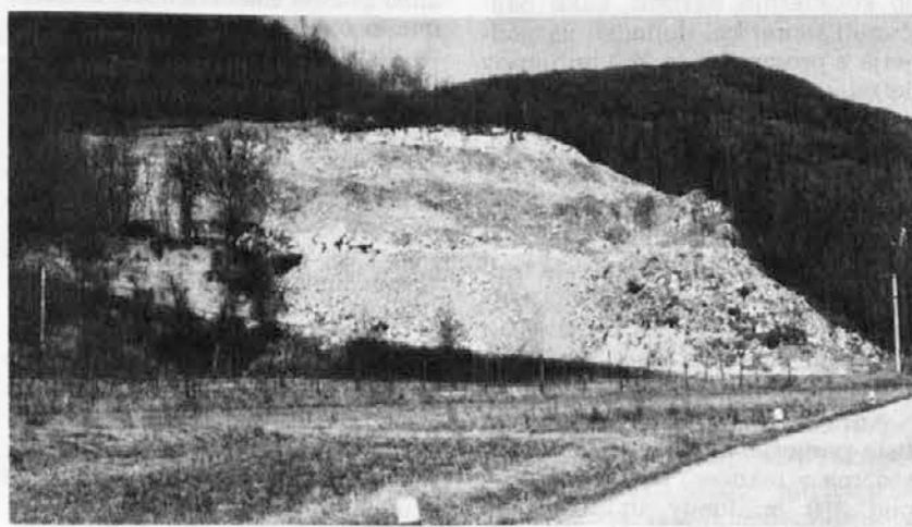
Una veduta della cava di Clastra
