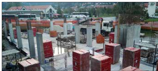
Objekt v izgradnji se nahaja tik ob regionalni cesti nasproti glavne avtobusne postaje.
