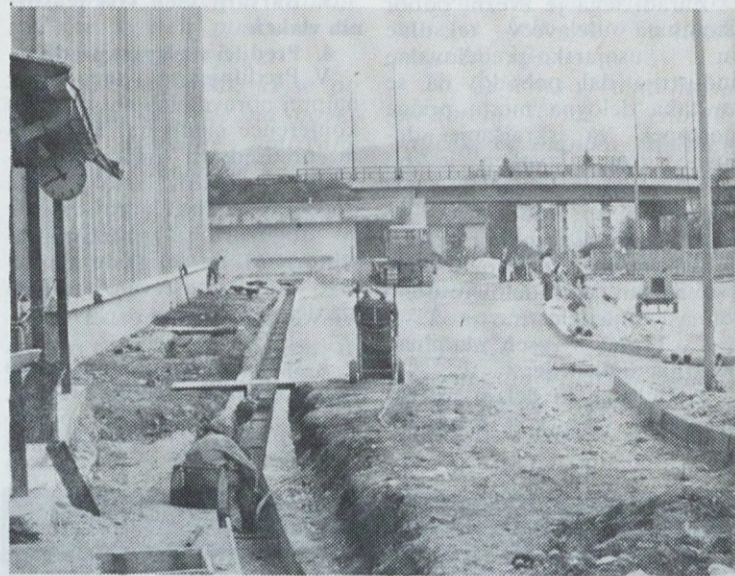
Gradnja instalacijskih priključkov.
