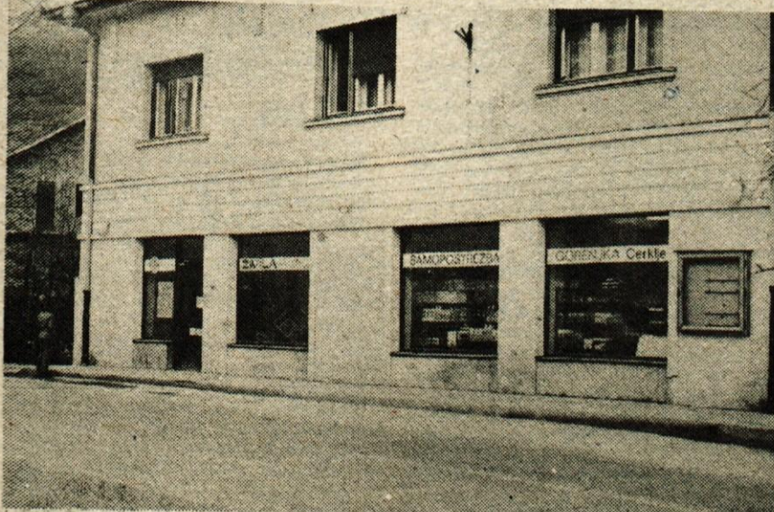
Prenovljena trgovina v Cerkljah — V stavbi nasproti milice v Cerkljah, kjer je bilo več let skladišče pohištva in drugega blaga, je Veletrgovina Živila Kranj uredila novo samopostrežno trgovino. Založena bo predvsem s prehranbenimi in drugimi izdelki. Nova trgovina bo precej obogatila in izboljšala preskrbo v Cerkljah, dobrodošla pa bo tudi obiskovalcem Kravca in izletnikom. Odprli so jo v soboto, 12. marca. — A. Ž.
