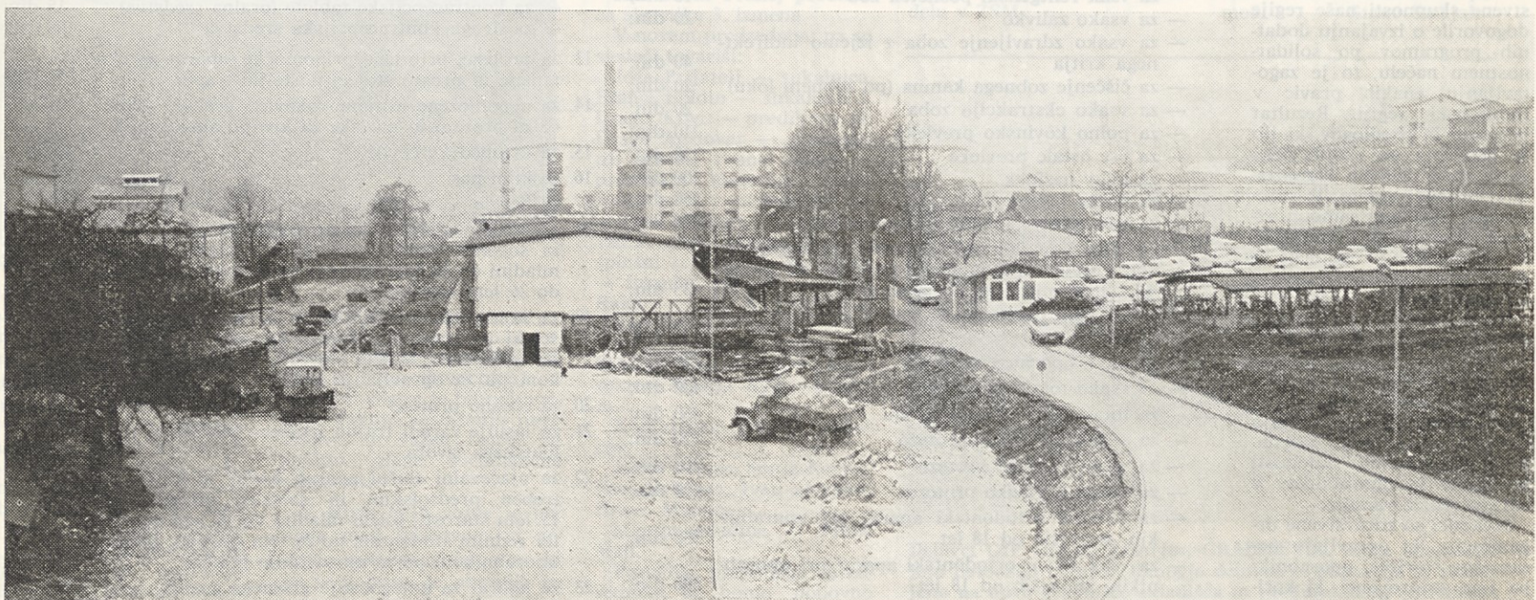
Na našem gradbišču se je že marsikaj spremenilo
