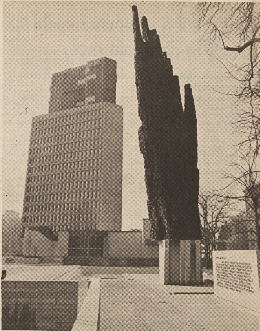
Mogočno kipi v višino naša stolpnica na Trgu revolucije. Ob končani prvi fazi izgradnje s tem v zvezi na straneh 5-8 objavljamo posebno prilogo o njej.
