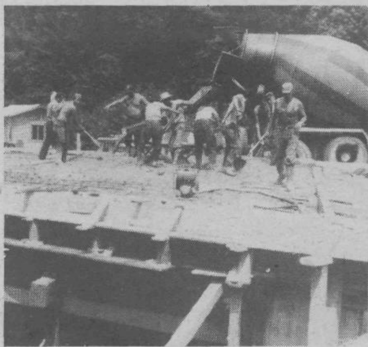
Gradnja mostu v Besnici (Foto C. Zupancič)
