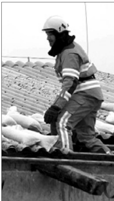
Gasilci na delu na strehi
