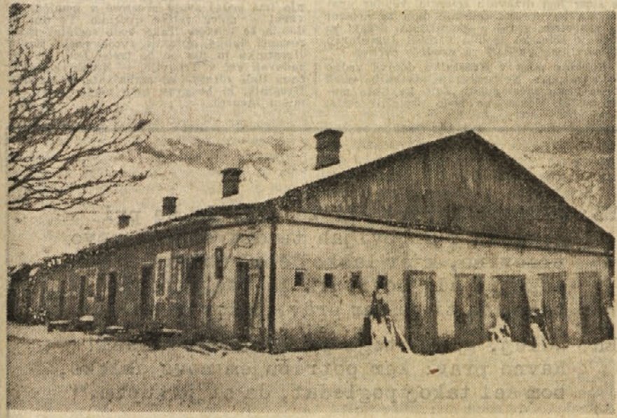
Stanovanjske hiše na Doberni, ki jih je gradila še bivša TPD, bo treba porušiti
