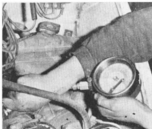
Merjenje kompresije v cilindrih
