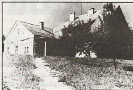
Povečana stavba OS Turje
