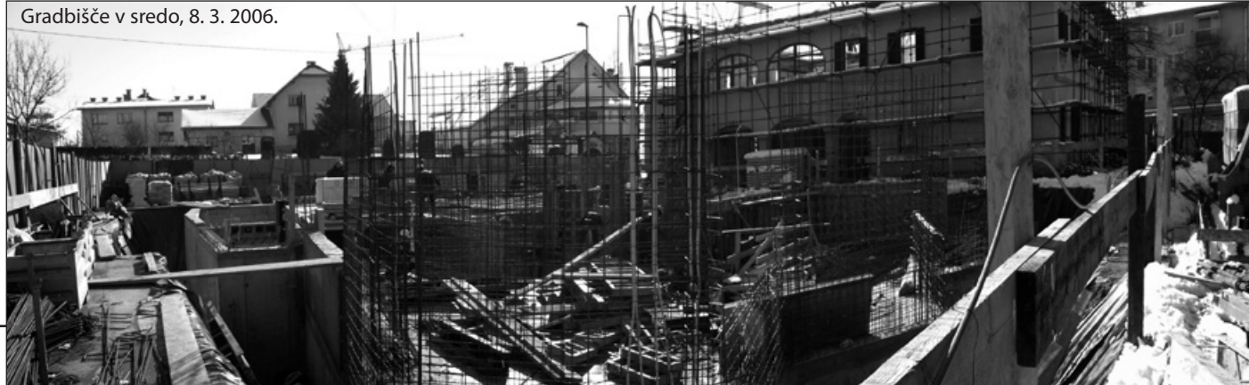
Gradbišče v sredo, 8. 3. 2006.
