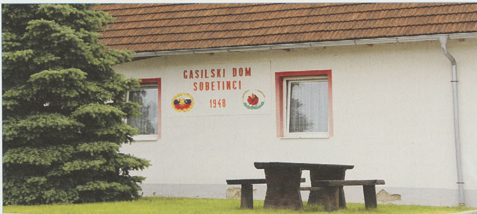
Gasilski dom v Sobetincih je v središču vasi. Kmalu se bo na tem mestu pričela gradnja in Sobetinci bodo dobili nov gasilsko-vaški-kulturni center.
