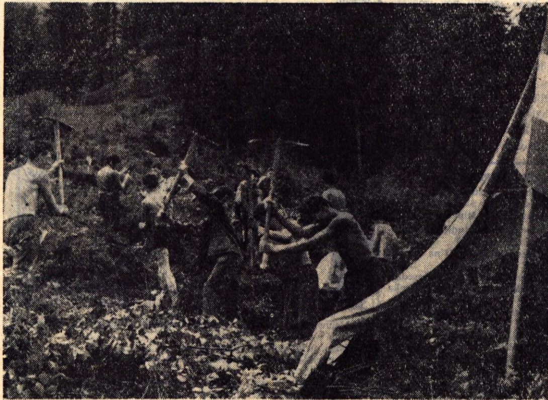
Brigadirji mladinske delovne brigade iz Ljubljane so na smučarskih terenih pod Vitrancem zasadili krampe, saj bo pozimi tam, kjer je bilo doslej gosto grmičevje, potekala smučarska proga
