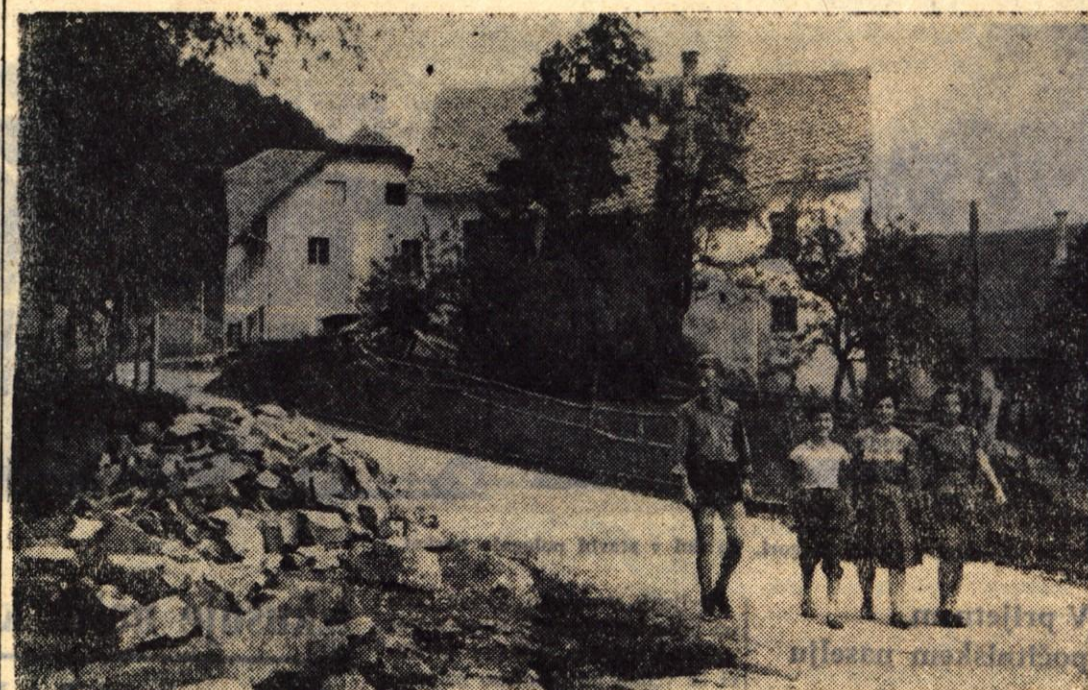
Na mestu, kjer bo stal spomenik Ivanu Groharju, je bila prej baraka, ki je ovirala pregled. Z zemeljskimi deli so postavitev spomenika že začeli, nanosili pa so tudi že kamenje iz Podrožanskega grabna. Med drugim bodo pred postavitvijo spomenika počakali na odgovor cestnega podjetja v Kranju
