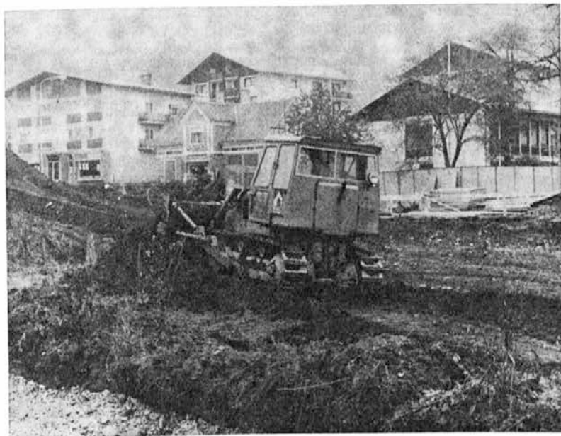
Temelji za družbeni dom na Prevaljah
