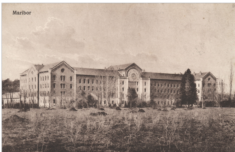
Kadetnica kot Inženirska podoficirska šola (PAM, fond 1693 Zbirka fotografij in razglednic)
