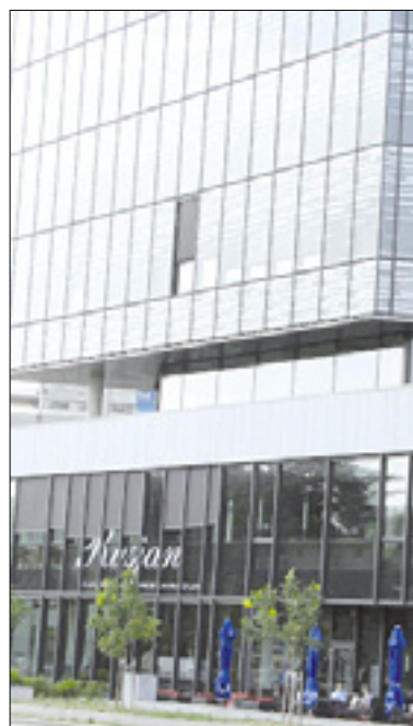
Odprtina na pročelju Eda centra KM
