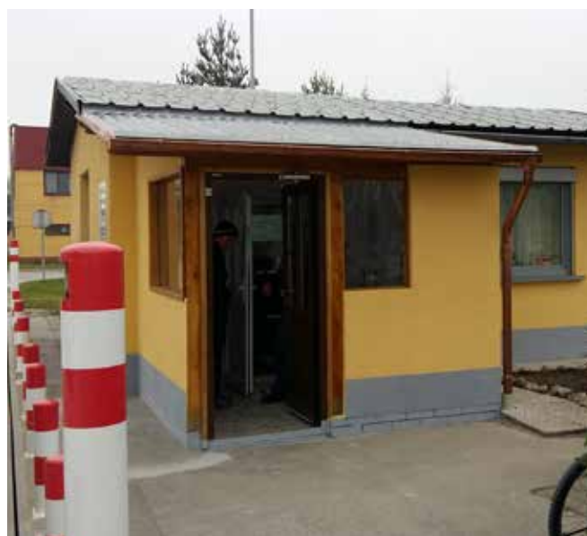
Novo zgrajen prizidek
