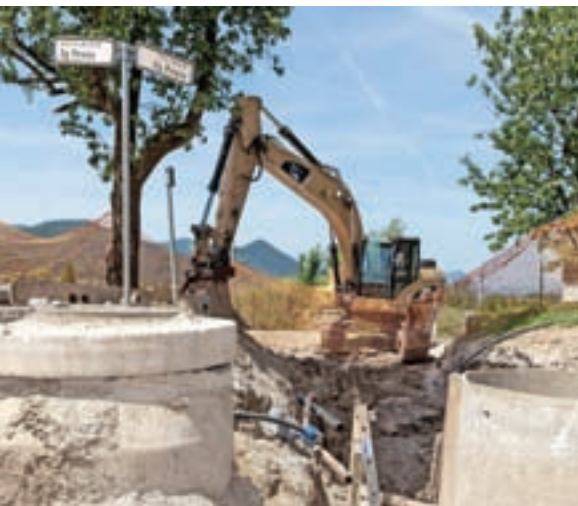
V KS Pirniče je odprtih veliko gradbišč. V teku je projekt kohezije. / Foto: Peter Košenina
