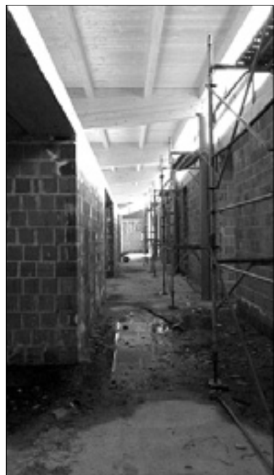
Gradbišče nove šole v Romjanu
