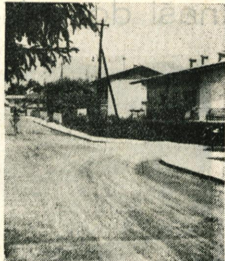
Asfalt na Rodici
