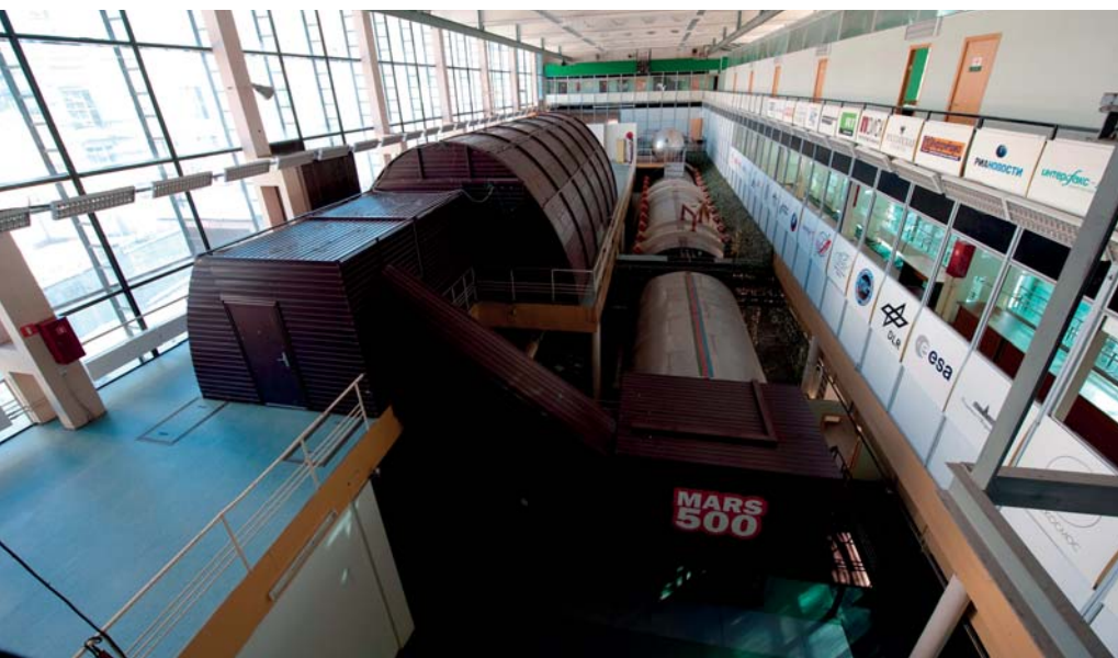
Mars v Moskvi: eksperimentalni medicinsko-tehnični kompleks GEC, sestavljen iz štirih modulov s skupno prostornino 550 m 3 (desno sta dva, največji pod simulatorjem levo in povprečni v ozadju pa se ne vidita) ter masivni simulator površine Marsa (rdeči modul)
