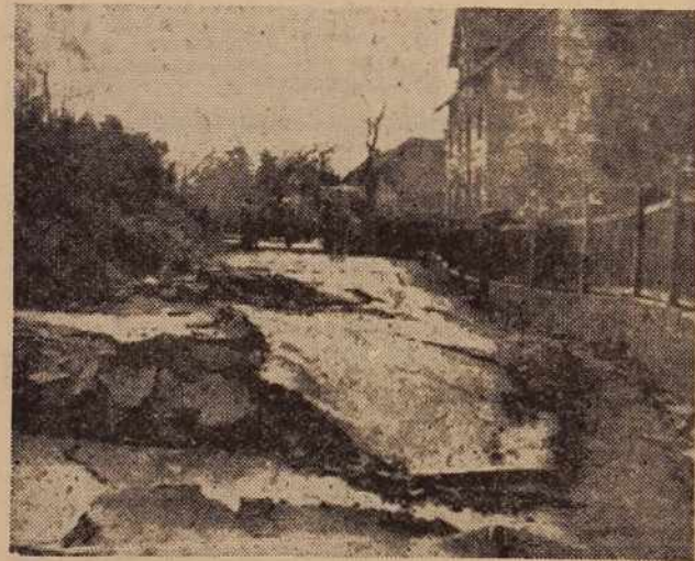
Cesta med Tržičem in Pristavo, ki jo je zemeljski plaz poškodoval
