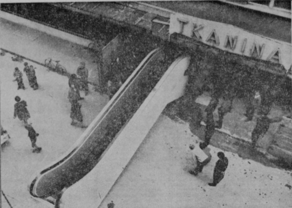
TKANINA MODERNIZIRA LOKAL — Ko bo odprt novi del blagovnice Tkanine v Celju, bodo tudi kupci z nadušo z lahkoto prišli do blaga v tretjem nadstropju. V prejšnjem tednu so namreč pripeljali premične stopnice, ki bodo kupce pripeljele v vsa nadstropja. Vlečne stopnice za eno nadstropje stanejo okrog 200.000 din, uvozila pa jih je Metalka Ljubljana iz Italije od firme Falconi-Novara. Pri Tkanini želijo, da bi novi del čimprej odprli za javnost ter tako še povečali izbiro.
