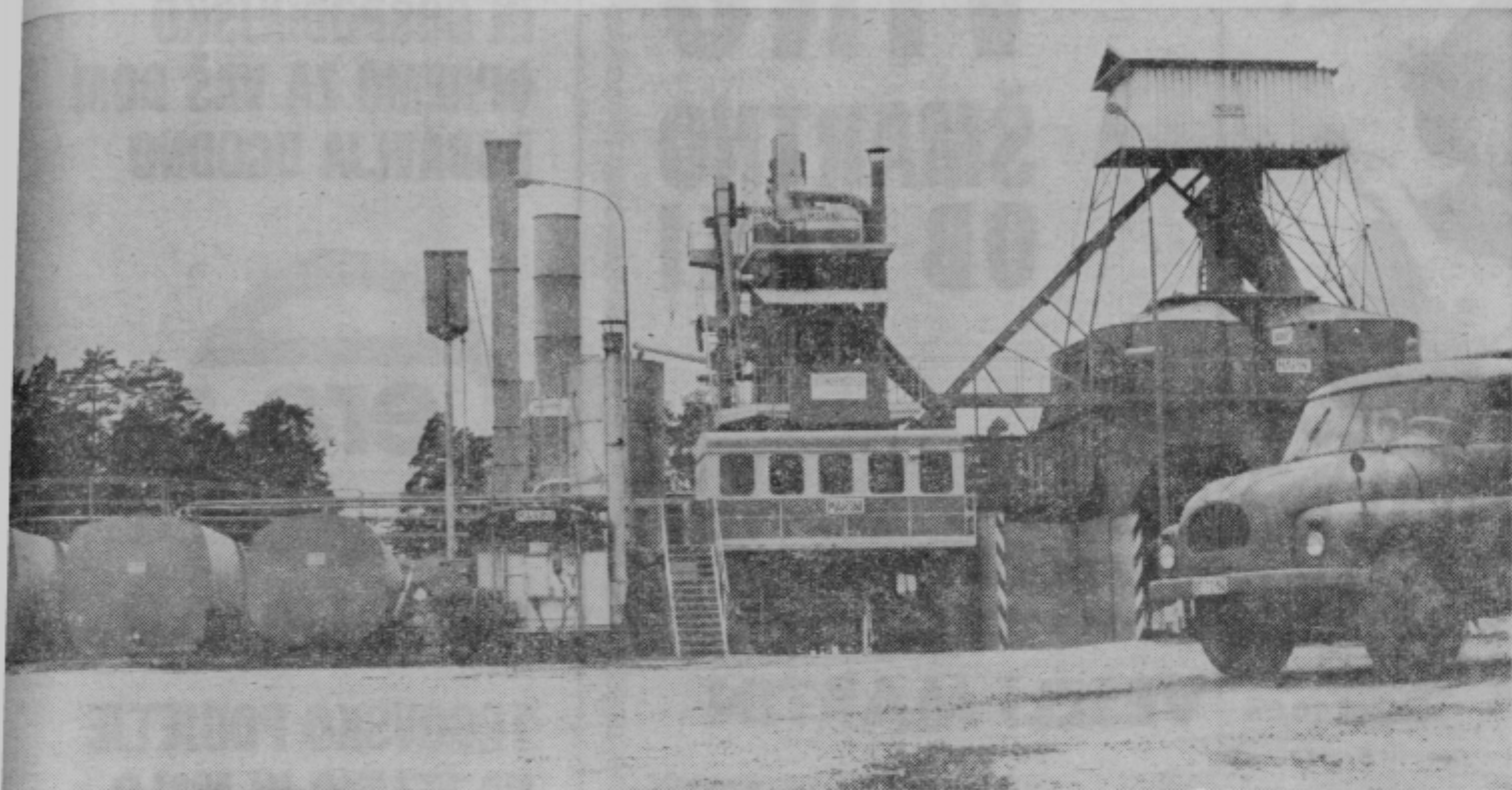
ova asfaltna baza v Veliki Pirešici, ki je letos zamenjala staro in s tem kolektivu omogočila, da je proizvodnja asfaltov dosegla potrebe, je eden izmed osnovnih faktorjev za uspešno delo in poslovanje kolektiva Cestnega podjetja v Celju.
