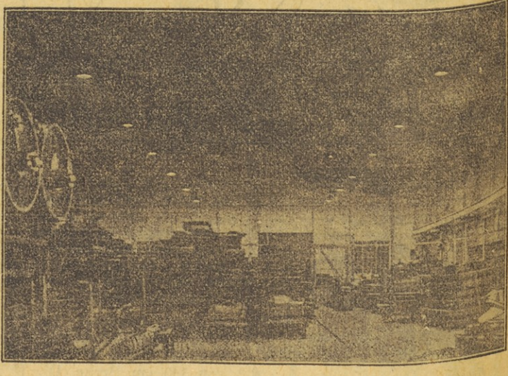
Beleuchtung einer großen Werkhalle durch Quecksilberdampfampfen HgH 2000 (je 22.000 Heiner-Lumen bei 475 Watt Leistungsaufnahme).
