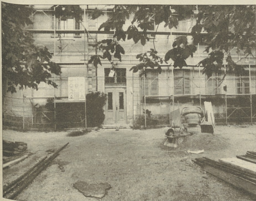
»Gradbišče« na dvorišču boljunške šole Frana Venturinija (foto KROMA)
